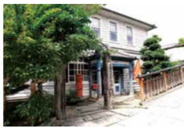
1 日本大正村役場 元役場を利用した施設で、無料資料館兼休憩所となっています。 見学料 無料 休館日 年末年始
